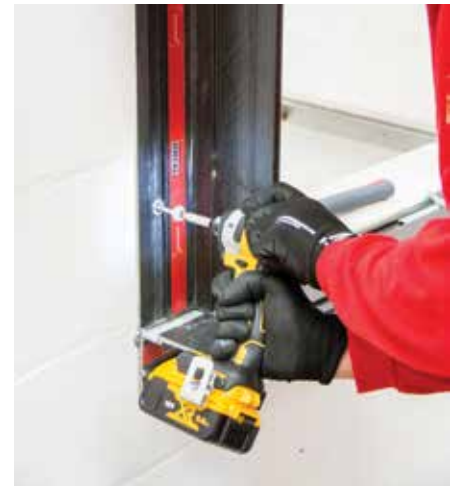
11 Fixer le cadre avec des fixations mécaniques adaptées
