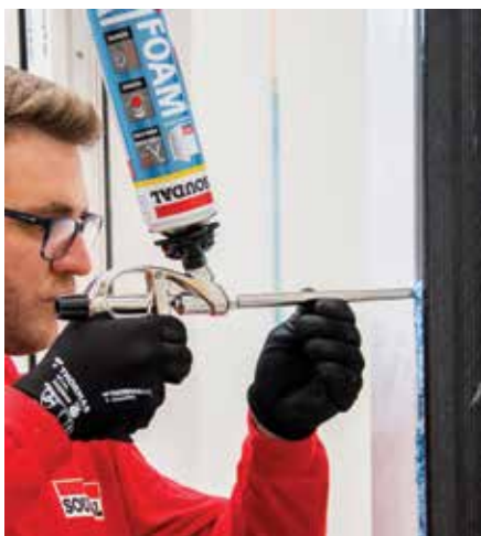
15 Retirer les clips ressorts et calfeutrer la connexion entre le précadre et le châssis
