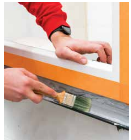
17 Terminer l'étanchéité avec Soudatight Hybrid en intérieur
