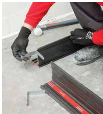
03 Insérer le connecteur d'angle
