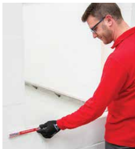
01 Mesurer l'ouverture de la maçonnerie
