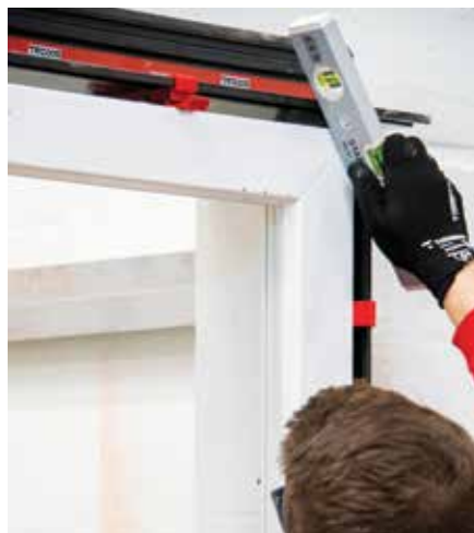
13 Préparer la fenêtre pour sa fixation, l'insérer et la régler
