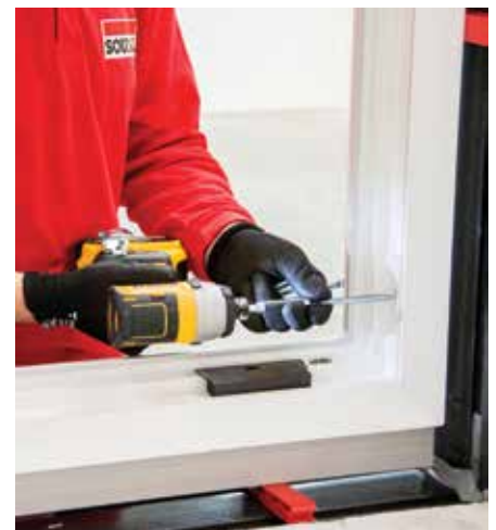
14 Fixer la fenêtre mécaniquement dans le précadre
