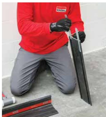
04 Connecter 2 profilés du cadre ou des chutes restantes avec les connecteurs de longueur
