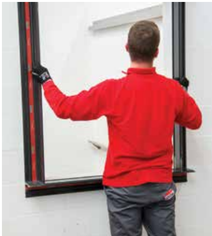
09 Prendre le cadre en main et presser contre le support en ajustant de haut en bas et de gauche à droite
