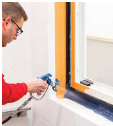
16 Terminer l'étanchéité avec Soudatight LQ/SP en intérieur
