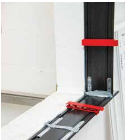
12 Jointoyer les angles intérieurs et positionner les clips ressorts
