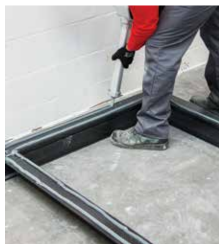
08 Appliquer la colle sur toute la périphérie du cadre avec 2 cordons parallèles
